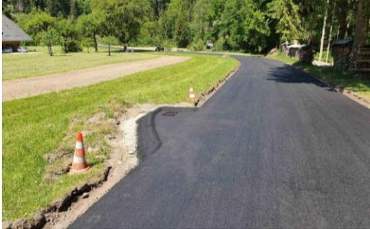
Im Mai wurde der Strassenabschnitt Sorbachbrücke bis Abzweigung Niederberg/Hüttenbödeli mit einem neuen Belag versehen. Gleichzeitig wurden auch defekte Entwässerungsleitungen ersetzt.
